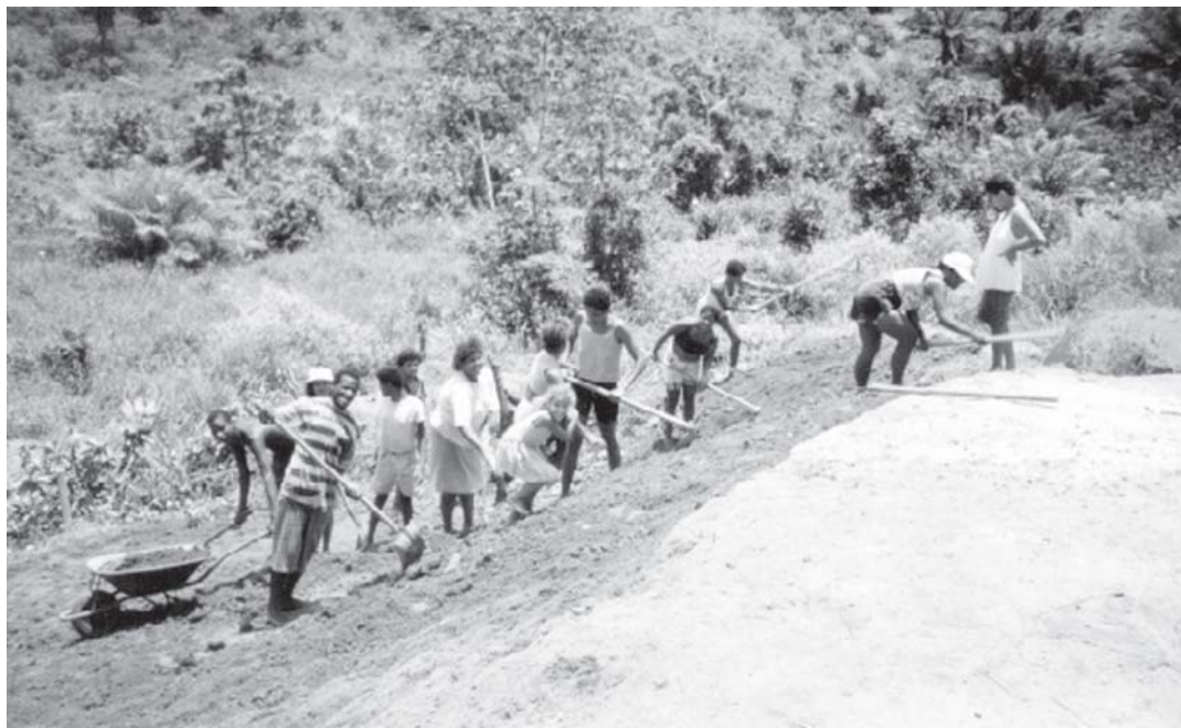
Voluntários trabalham para limpar o terreno da futura creche em mutirão.
